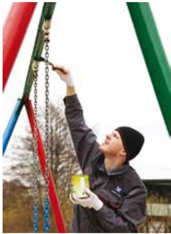
Kiigekonstruksioonid ja ronimiskonstruksioonid puhastati ning värviti kirevat tooni värvidega.
